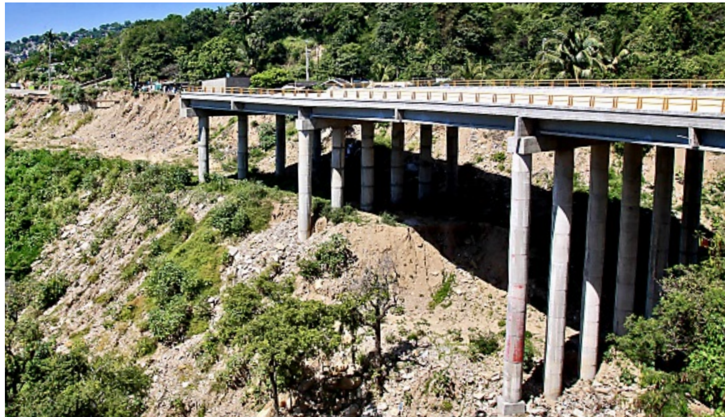
TIENDEN PUENTES. Dentro del proyecto de ampliación de la carretera de Mozimba a Pie de la Cuesta está contemplada la construcción de seis puentes, dos de ellos ya operan.
